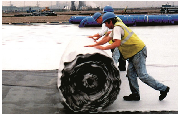
Fig. 5: Pozidrain rolling out
